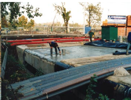
Hydroizolacja wierzchu stropu tunelu świętokrzyskiego, Warszawa
