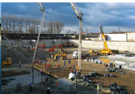
Hydroizolacja płyty fundamentowej oraz zamka ściany szczelinowej, Kraków
