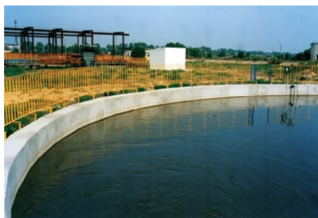
Hydroizolacja oczyszczalni ścieków, Bielsk Podlaski
