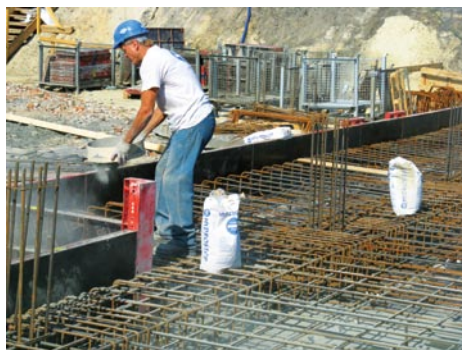
Hydroizolacja spodu płyty fundamentowej, Katowice
