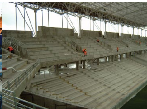
Hydroizolacja elementów betonowych korony stadionu, Kielce
