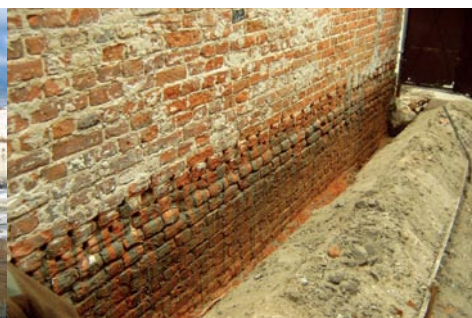
Odtworzenie izolacji pionowej i poziomej, Białobrzegi
