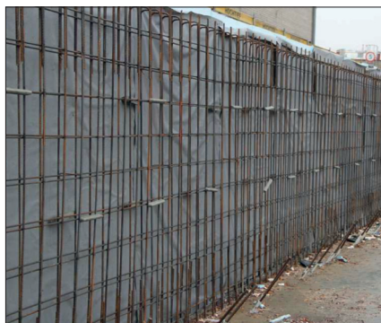
Fot. 4. Ścianka berlińska przy granicy działki z przygotowaną do betonowania izolacją krystalizującą w formie rolowej
