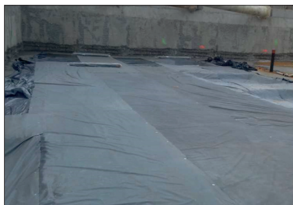
Fot. 5. Mata penetrująco-krystalizująca rozkładana pod płytą denną między ścianami szczelinowymi
