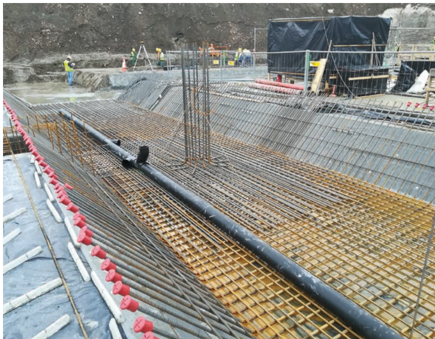
Fot. 2. Przeglądanie w płycie fundamentowej. Widoczna Hydrostop-Mata Penetrująca
