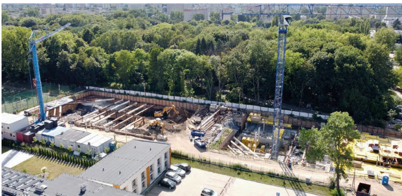
Fot. 3. Zespół budynków wielorodzinnych w mieście Łódź. Izolacja płyty – Hydrostop-Mieszanka 203 na powierzchni ok. 3600 m 2
