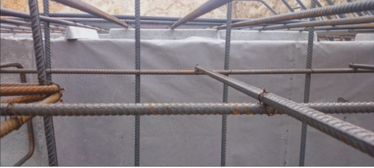
Fot. 1 | Mata Penetrująca zastosowana na styku dwóch elementów konstrukcyjnych
