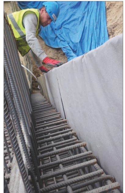
Fot. 2 | Montaż maty na boku płyty fundamentowej
