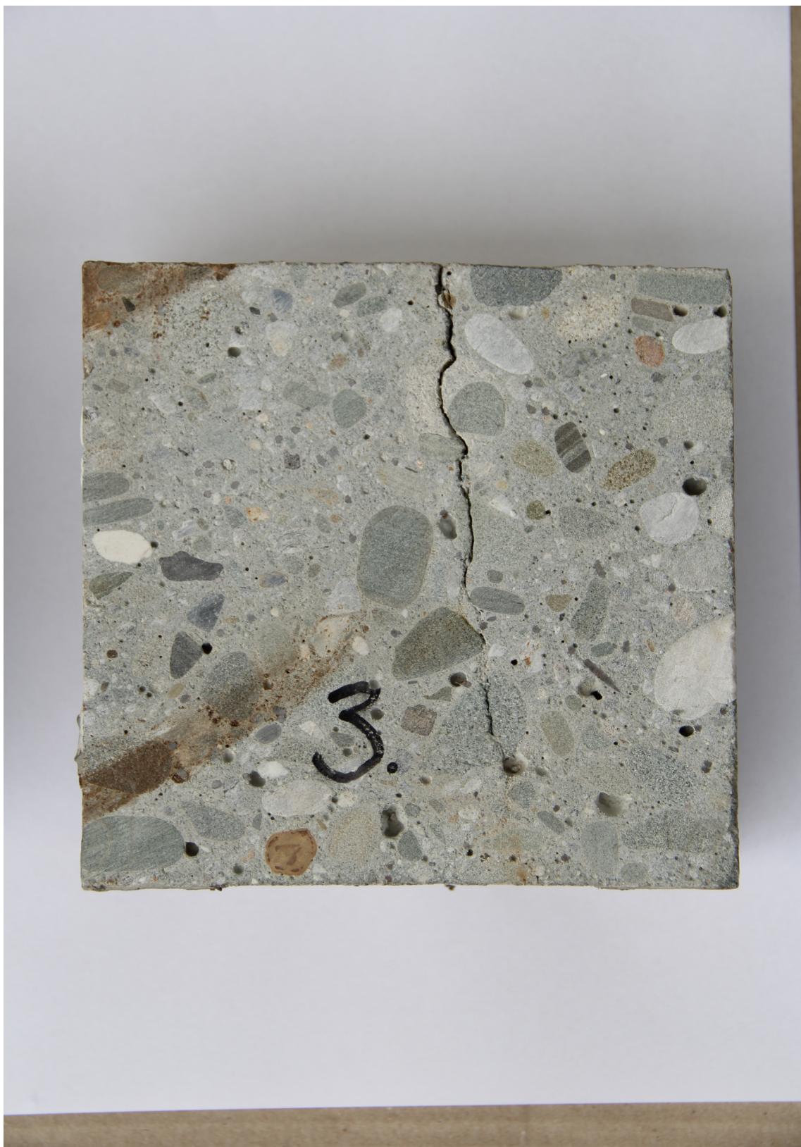
Fot. 1. Kostka z widoczną, częściowo zarośniętą rysą. Na przekroju kostki są też ślady brązowe po cięciu tarczą stalową, której pozostałości na powierzchni zamieniły się na brązowy tlenek żelaza. Zdjęcie w świetle dziennym.
