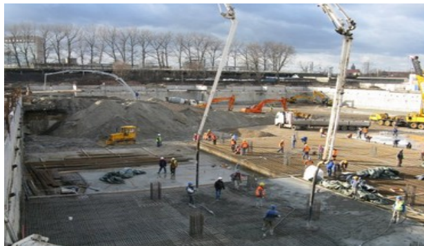
Fot. 1 Podziemia uszczelnione Hydrostopem.
