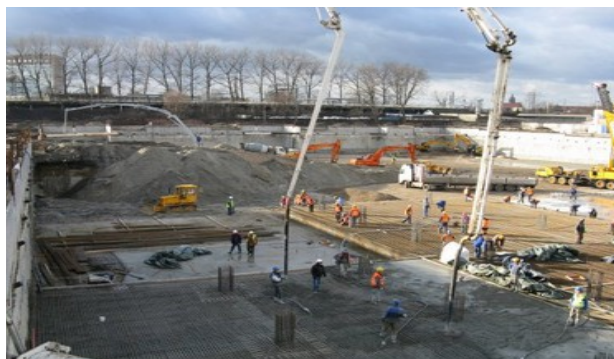
Fot. 1 Podziemia uszczelnione Hydrostopem.
