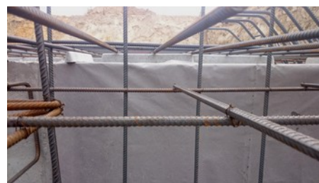
Fot. 2: Uszczelniona Matą Penetrującą powierzchnia ściany przegłębienia płyty fundamentowej.
