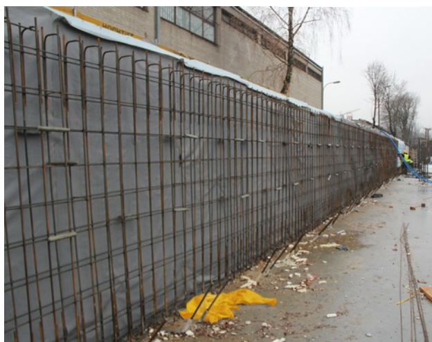
Fot. 1. Montaż Maty Penetrującej na zewnętrznej stronie ściany fundamentowej garaży podziemnych.
